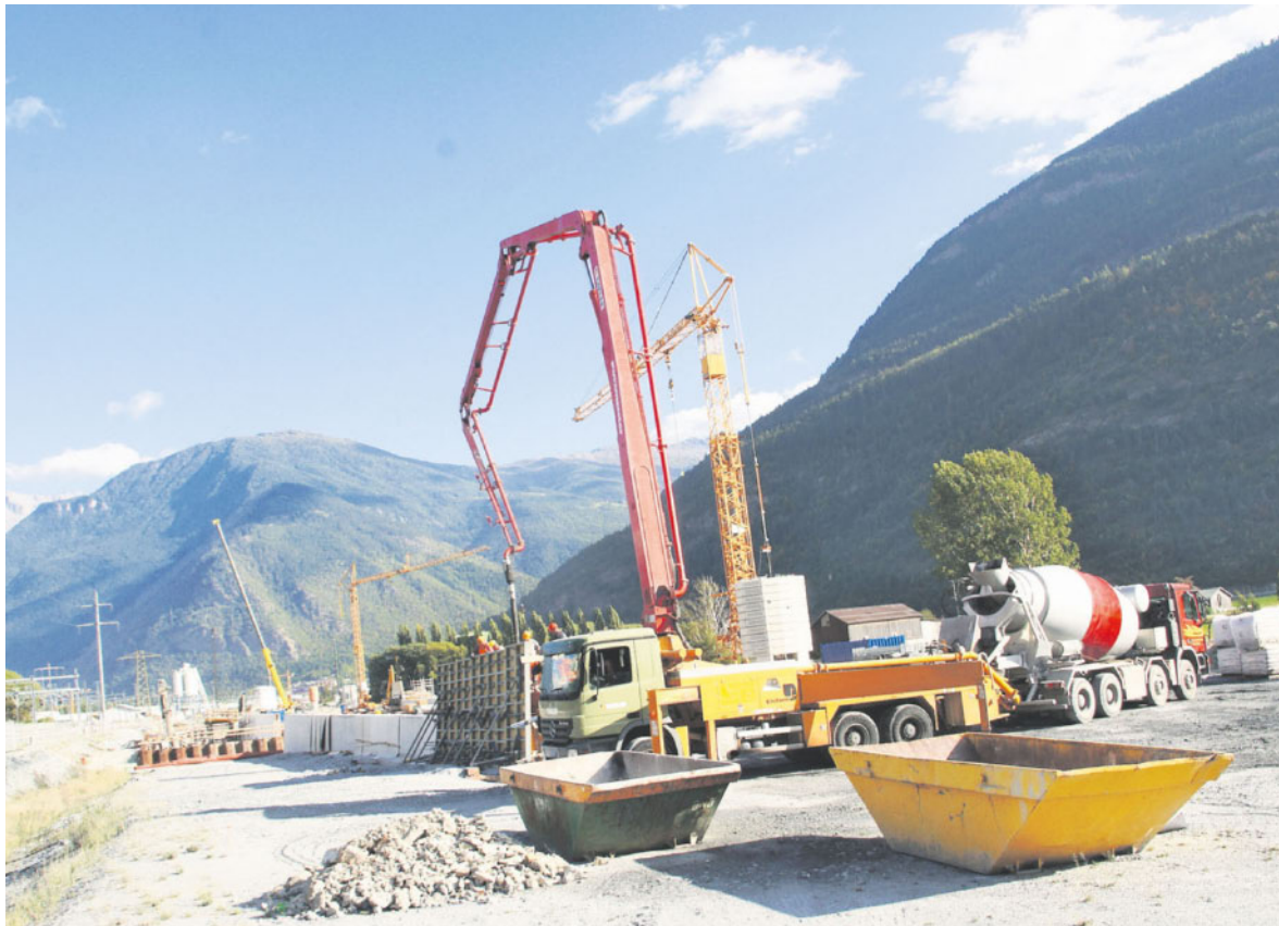
Auf Kurs. Im letzten Jahr wurde auf den verschiedenen Baustellen viel gearbeitet und einiges bewegt.
