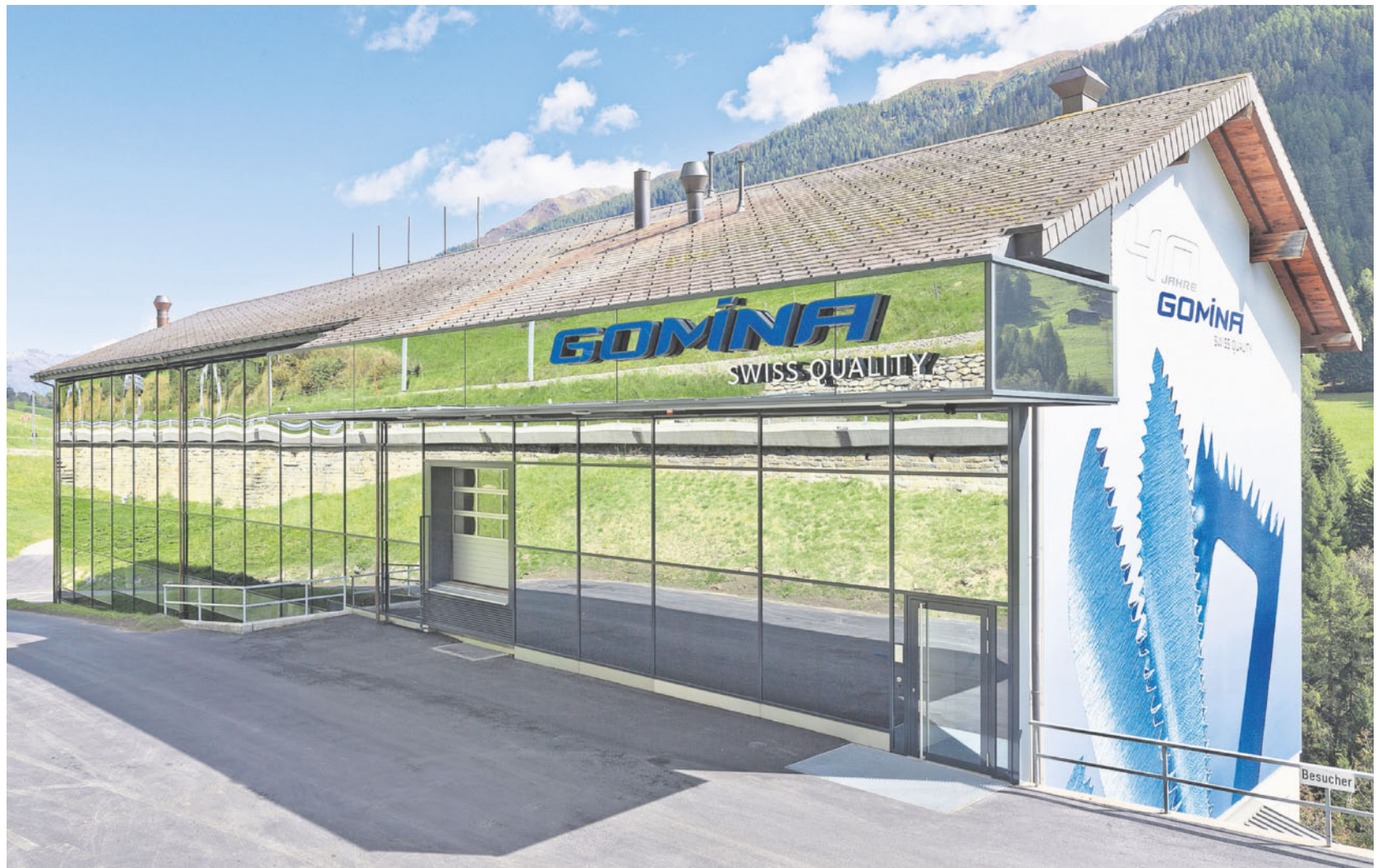
Modern. Die Gomina verpasste sich zum Jubiläumsjahr eine moderne Fassade. Diese entspricht den Produktionsräumen und Anlagen im Innern, die sich auf dem neuesten Stand der heutigen Technologie befinden. Das garantiert die gewünschte Produktepräzision und Sicherheit.
